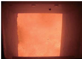
焼却炉の中。ごみを燃焼中。
