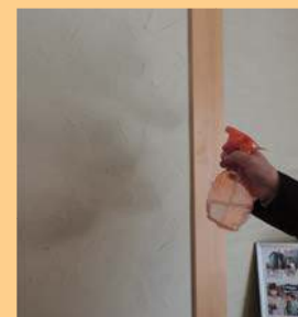
▲きりふきで水を吹きかけても、水分を吸収する高千穂産のシラス壁
